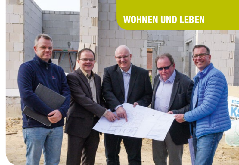
Besichtigung der Baustelle (v.l.): Bauleiter Guido Tiemeier, HpH-Geschäftsführer Guido Uhl, Architekt Andreas Küpker, Badbergens stellvertretender Bürgermeister Werner Meier und NPZ-Einrichtungsleiter Christoph Pieper. Foto: Elisabeth Schomaker
